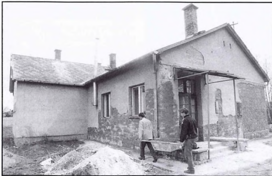
Felújítás alatt az önkormányzat épülete
